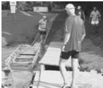
Umsetzanlage mit Gleislöre
