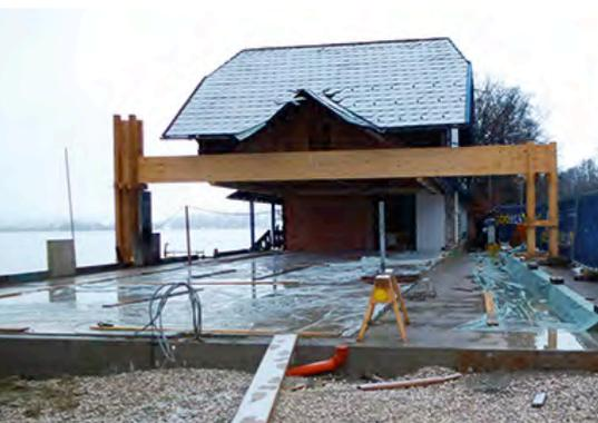
Das Untergeschoß der Bootshalle, ein Betonbau aus der Zeit um ca. 1880 war in seiner Bausubstanz bereits in einem äußerst schlechten Zustand, hervorgerufen durch die jährlich wiederkehrenden Hochwässer und Wassereinbrüche bei Regenwetter von der Straßenseite.
