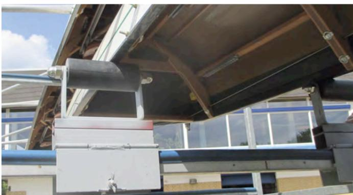
Die Bootsrolle wird temporär montiert und nach der Position des Bootes wieder abgenommen
